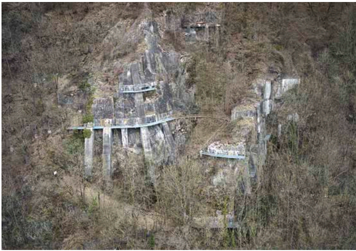
Fels- und Hangsicherungen, Stützbauwerke
