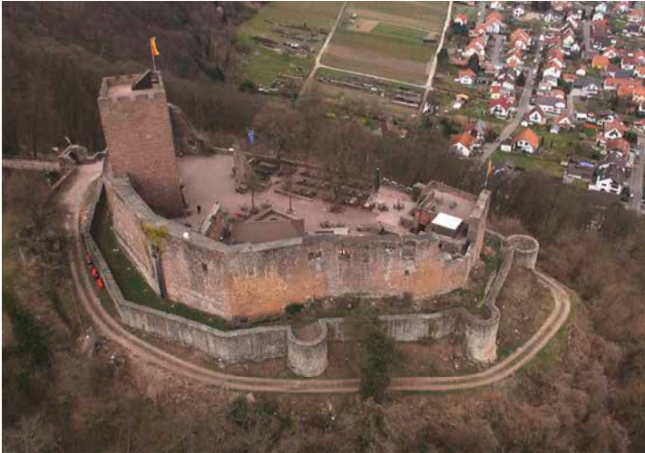
Burgen, historische und archäologische Anlagen
